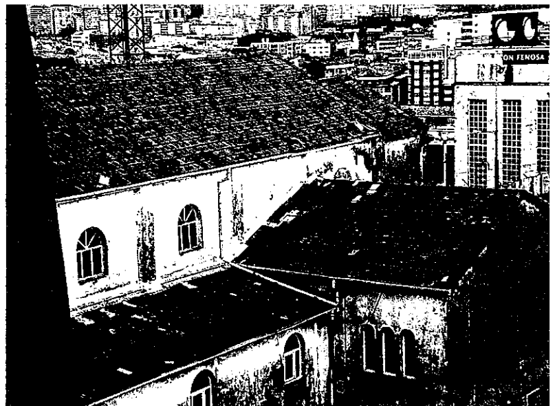
El temporal levantó varias tejas de la iglesia de Santa Mariña, situada al lado de instalaciones de Fenosa
