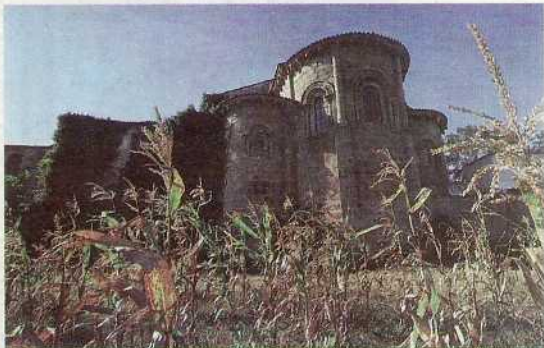
Las hiedras cubren desde hace tiempo parte de los muros de la construcción, contribuyendo a su deterioro
