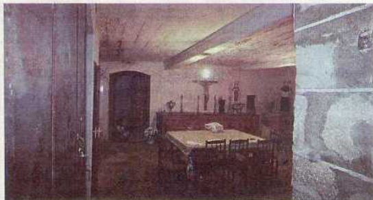
En la sacristía del templo también se realizarán algunas reparaciones, sobre todo en la cubierta
