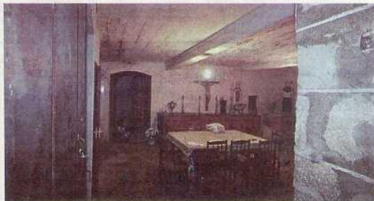
En la sacristía del templo también se realizarán algunas reparaciones, sobre todo en la cubierta
